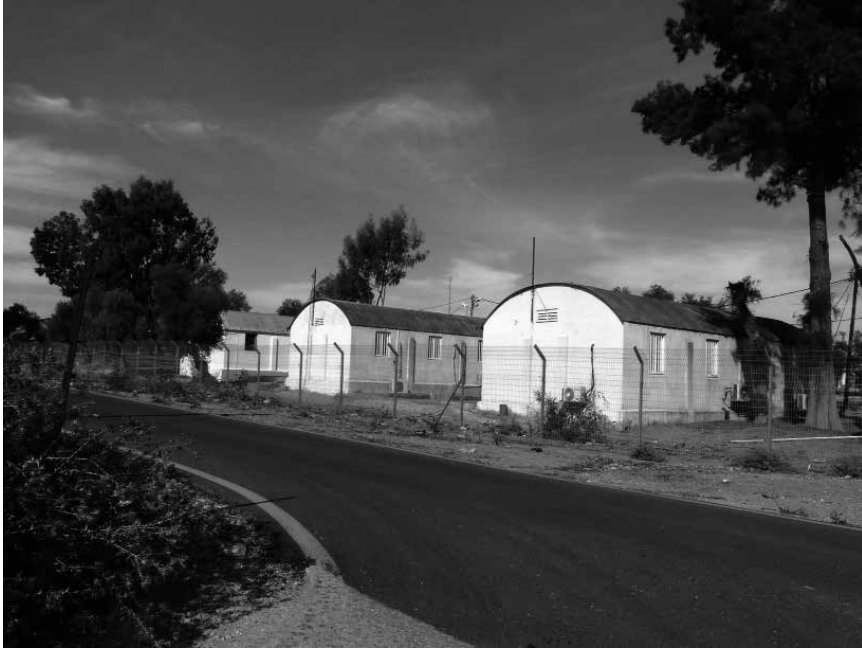
מחנה רמלה: שני מבני ניסן בריטיים שנבנו במלחמת העולם השנייה. קירות מקבילים בנויים לבנים עם טיח על מסד יצוק בטון, וחיפוי פח גלי צילום: שרי מרק, 2010, אוסף פרטי.
