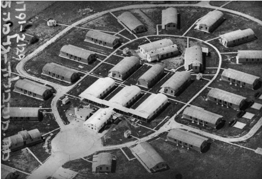
בסיס התעופה הבריטי מוקבילה, 1948. מערך צריפי ניסן בסגנון מקומי למגורים. הקמרון מפח גלי והמעטפת הקבועה של הקירות האנכיים נבנתה מלבנים עם קורות בולטות לחיזוק, עם חלונות ועם פתחים בהיקף המבנה. באדיבות ארכיון צה"ל ומערכת הביטחון.
